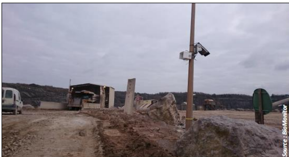
Figure 199 : microstation 2 – proximité du concasseur primaire (carrière B)
