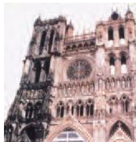
Dépôts de particules sur le calcaire de la cathédrale d'Amiens
