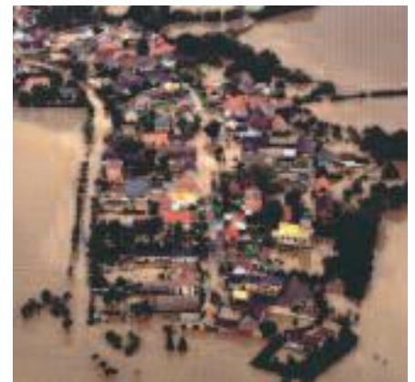
Inondation, un des risques observés
