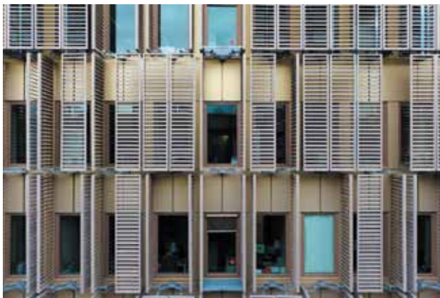
Des persiennes de mélèze servent de protections solaires aux fenêtres de cet immeuble de bureau.
