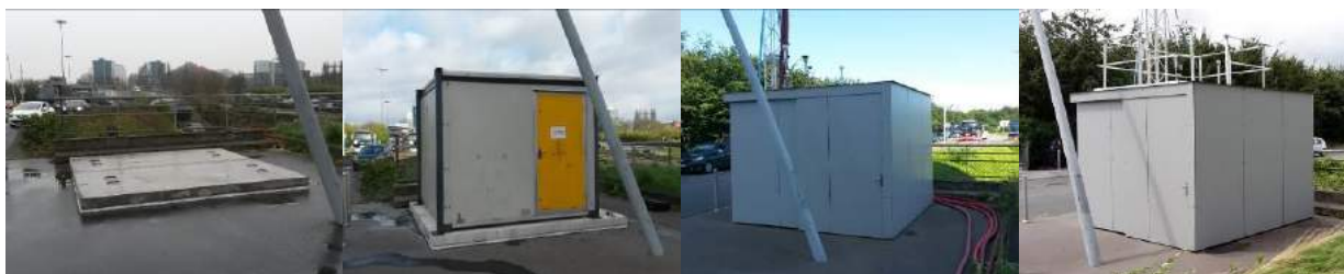
Pose de la dalle en béton
