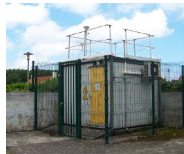
Station fixe installée dans la cour de l'école Pollet, rue de l'Eglise. ©AtmoHdF
